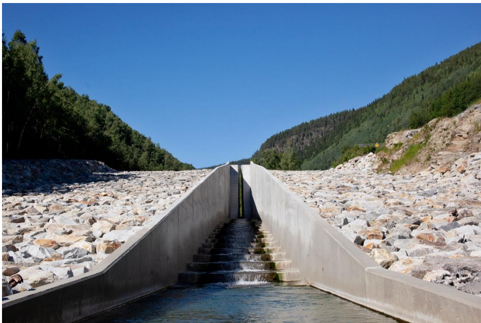
Figur 3.6 Bunnlastsperren fotografert 8. august 2018
