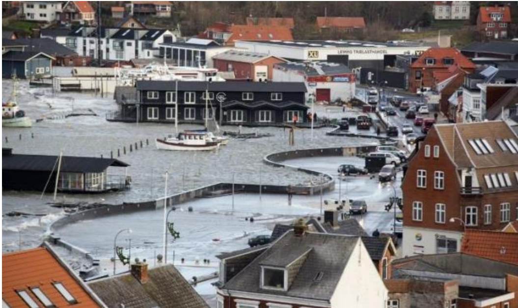
Figur V3.10 Illustrasjon på mur som stormflosikring på land fra Lemvig
